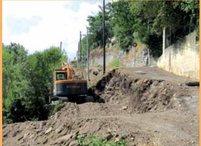
L'acheminement de grosses pierres a permis la construction d'un mur de soutènement de 150 mètres de long et 4 mètres de haut.
